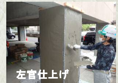
SRF(耐震補強) 施工状況
